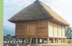
⑨〈板倉〉武器を保管した倉庫です。
